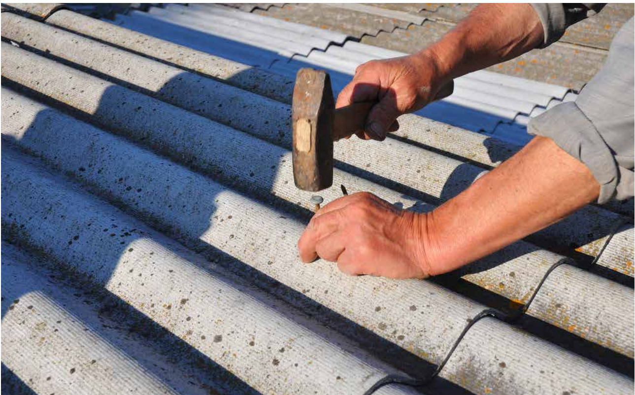
Amiante toiture : situation de travail
